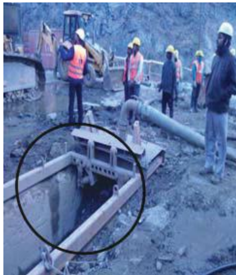
Fig. 11 - A guide wall
